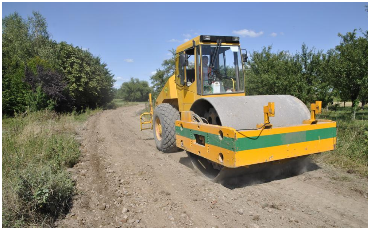
Le premier tronçon sera terminé mercredi. La piste cyclable devrait être ouverte dans sa totalité d'ici trois semaines. PHOTO DNA
