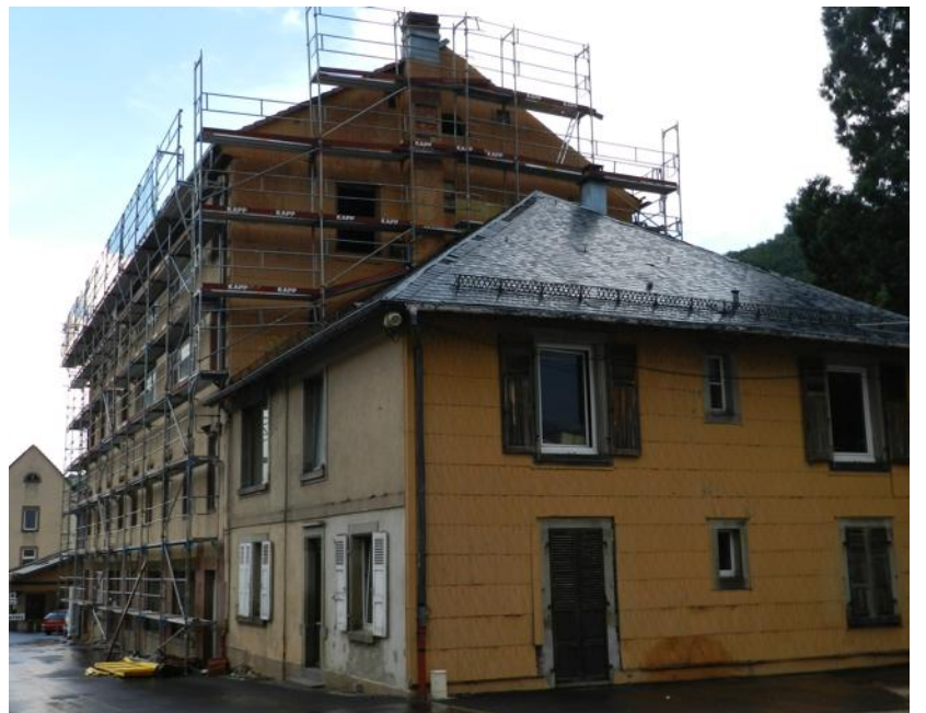
À Sainte-Marie-aux-Mines, une ancienne usine est en cours de rénovation par la communauté de communes du Val d'Argent. PHOTO DNA
