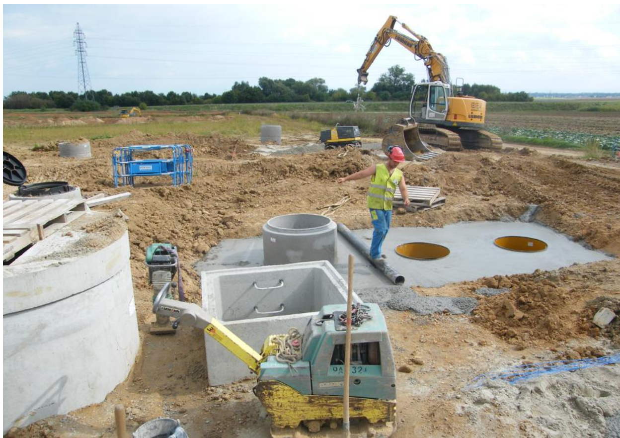
Le parc d'activités économiques intercommunal a vu en été le démarrage des travaux d'aménagement, avec la viabilité et les réseaux. PHOTO DNA – CLAUDE ROBINET
