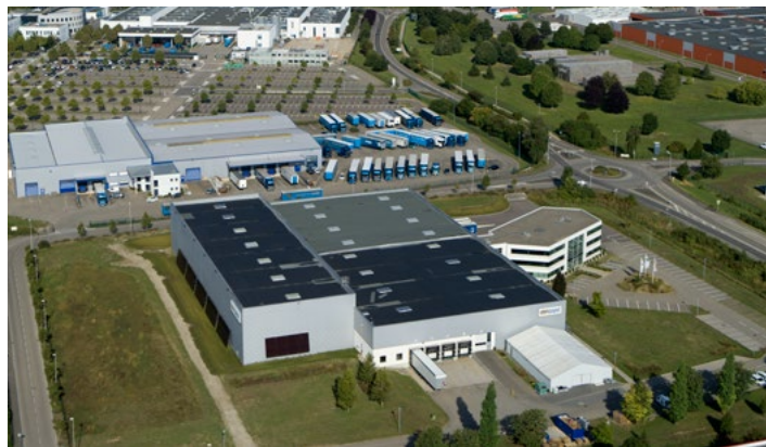
Extension de 2 200 m 2 de l'entreprise Ebm Papst
