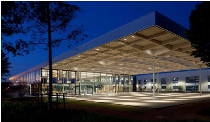
Construction du Forum Hager
