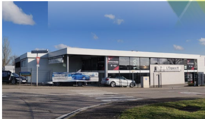
Installation de l'Espace H
