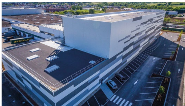
Investissement de 10 M€ / 3 300 m 2 pour la nouvelle plateforme logistique Triumph
