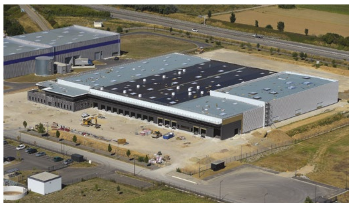
Construction de la plateforme EST-PR de 10 000 m 2
