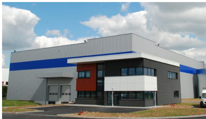
Transports Huck : construction d'un hall de stockage et de production
